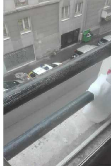
Photo 2 : Pièce principale - Garde-corps en zone E
