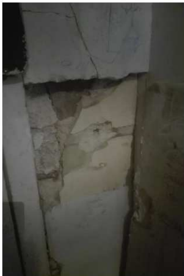
Photo 3 : Pièce principale - Mur A
