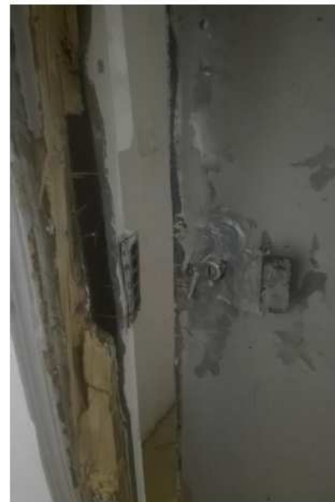
Photo 4 : Porte d'entrée (Extérieur)
